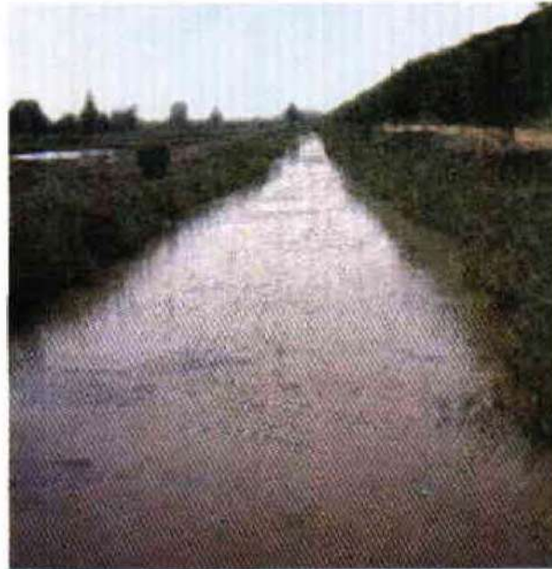
FIGURA 25. Canal de derivación
