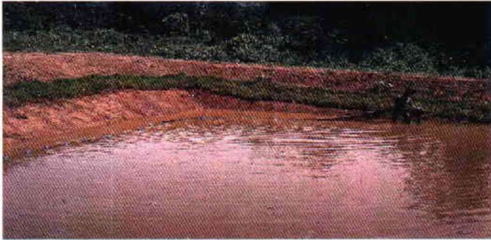
FIGURA 23. Cobertura del dique para protección.
