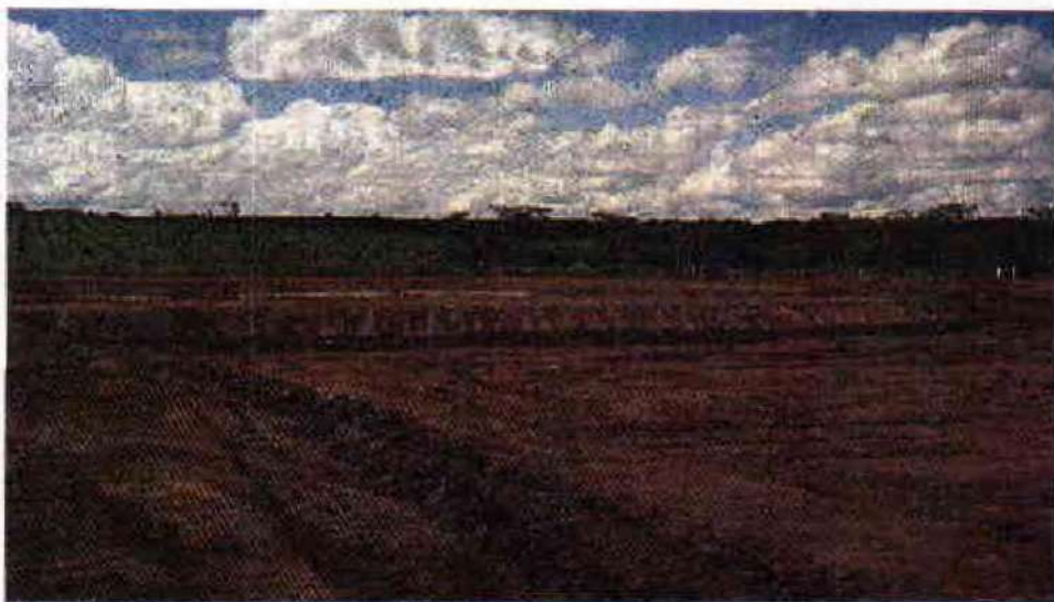
FIGURA 22. Compactación y apisonado de diques
