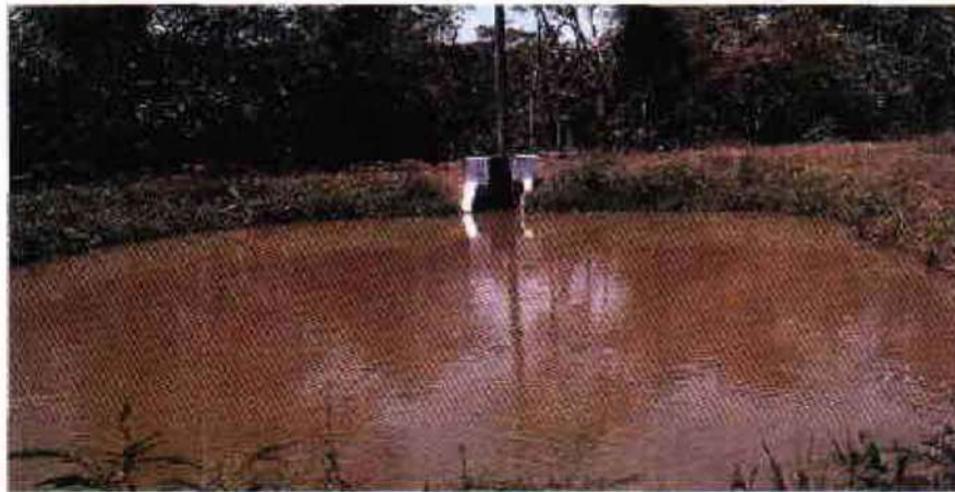
FIGURA 33. Estanque desagüe tipo monje
