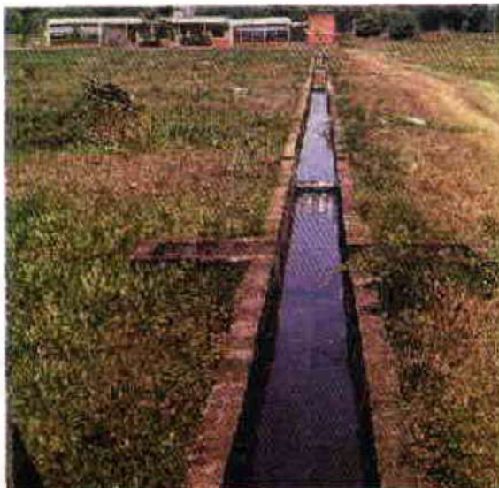
FIGURA 30. Canal abierto de alimentación de estanques
