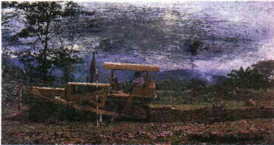
FIGURA 19. Descapote de un terreno para construir estanques
